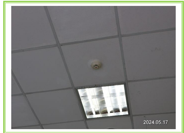
รูปที่ 3-46 เครื่องตรวจจับควัน
