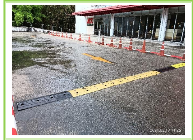
รูปที่ 3-8 เนินชะลอความเร็วบริเวณถนนในพื้นที่โครงการ
