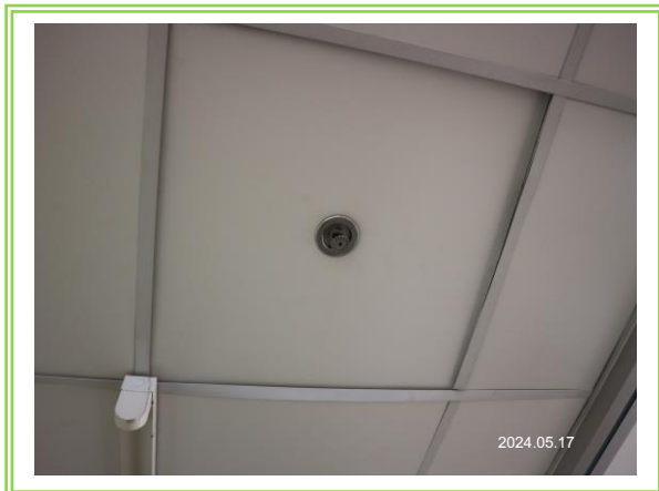
รูปที่ 2.7-3 หัวกระจายน้ำอัตโนมัติเมื่อเกิดเพลิงไหม้
