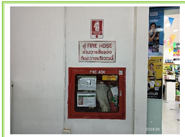
รูปที่ 3-47 ตู้เก็บสายดับเพลิง
